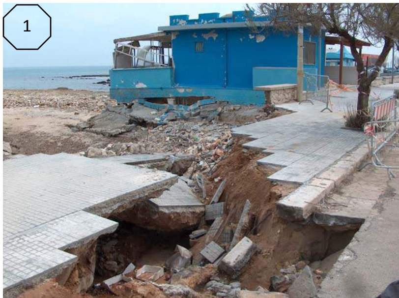
Fig. 7 – 8 - 1° focus erosivo - il tratto costiero del comune di Squinzano relativo al 1° tratto litorale in erosione, laddove fino a qualche anno addietro era presente una caratteristica pocket beach , spiaggia emersa di tipo basso sabbioso-ciottoloso; attualmente il processo erosivo ha determinato una rilevante variazione morfologica dell'ambiente costiero, con la sostituzione della spiaggia emersa con quella sommersa, ove di fatto vanno a collocarsi le strutture
