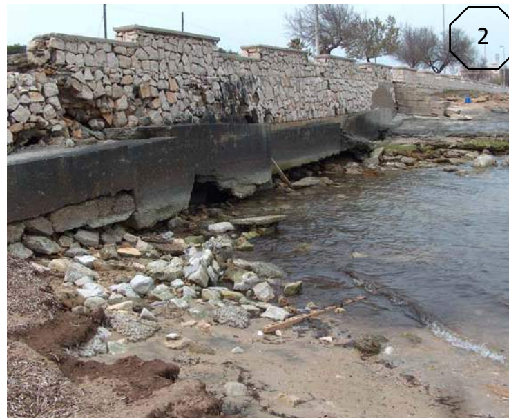
Fig. 7 – 8 - 1° focus erosivo - il tratto costiero del comune di Squinzano relativo al 1° tratto litorale in erosione, laddove fino a qualche anno addietro era presente una caratteristica pocket beach , spiaggia emersa di tipo basso sabbioso-ciottoloso; attualmente il processo erosivo ha determinato una rilevante variazione morfologica dell'ambiente costiero, con la sostituzione della spiaggia emersa con quella sommersa, ove di fatto vanno a collocarsi le strutture
