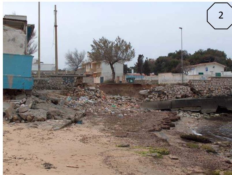
Fig. 12- 13 - Cedimenti della carreggiata pedonale e parziale interessamento della sede stradale del lungomare di Casalabate; nel tratto costiero sud vede oramai posizionati gli edifici degli anni '60 e '70 sulla attuale spiaggia sommersa, essendo quella emersa stata completamente erosa in questo intervallo temporale; sullo sfondo, l'edificio diroccato degli ex uffici locali della GdF, coincidente con il limite amm.vo tra i comuni costieri di Squinzano e Trepuzzi
