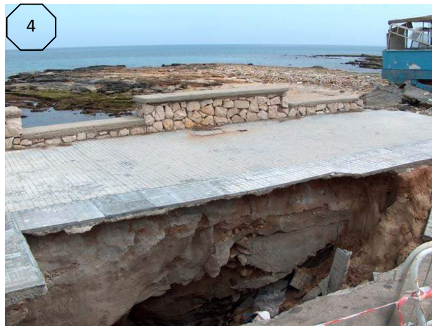
Fig. 9 – 10 - L'avanzata dei processi erosivi ha progressivamente collocato taluni tratti della sede del lungomare sulla spiaggia sommersa ed oltre la dividente demaniale; ciò a causa del progressivo arretramento della spiaggia emersa ( pocket beach ), oramai completamente scomparsa. Su questo tratto si propone la modifica della Criticità da C1 a C3
