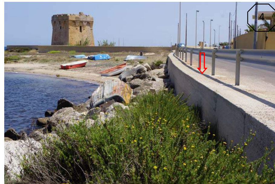
Fig. 30 - 31 – la linea di costa, essendo dinamica, attiva ed in evoluzione, mal si concilia con opere rigide riflettenti che accentuano il livello erosivo della spiaggia; banquette derivanti dallo spiaggiamento del posidonieto strappato ai fondali durante le mareggiate; il tratto costiero dopo i lavori di ripristino e consolidamento del rilevato stradale.
