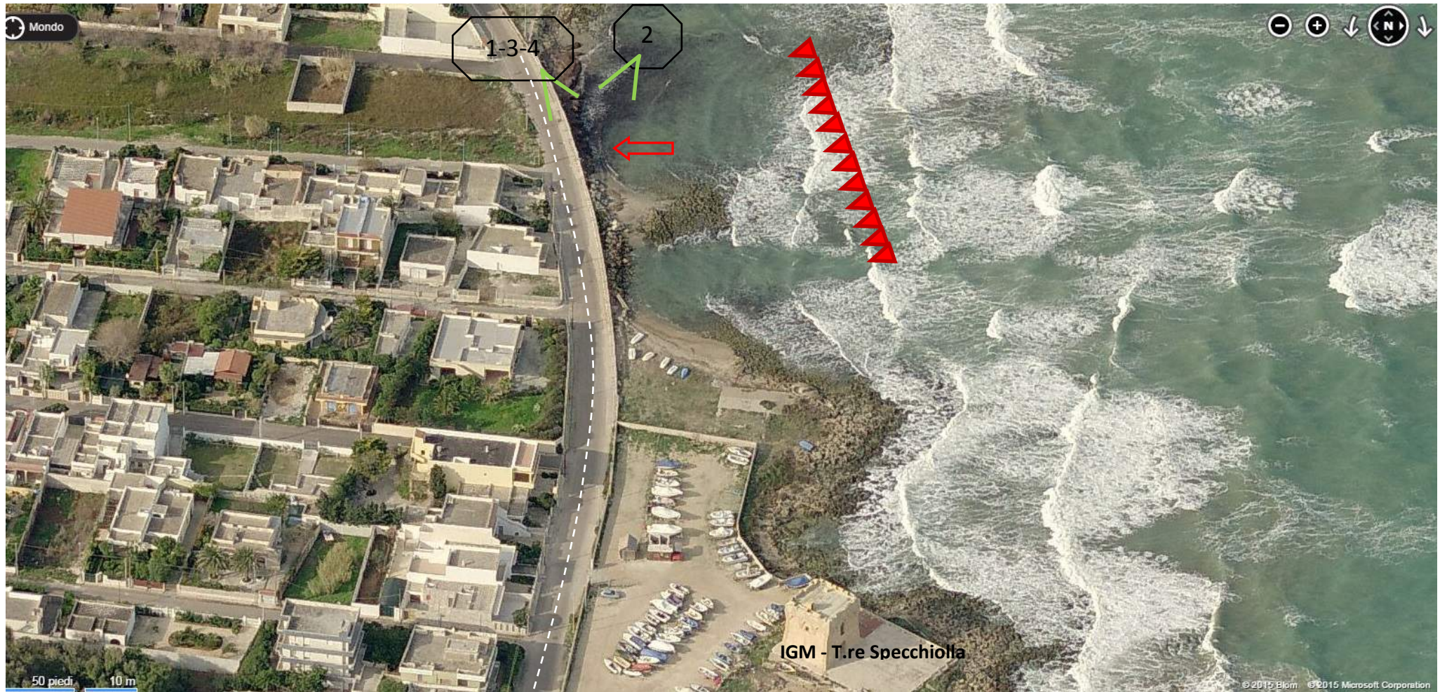
Figura 27 - L'edificio costiero di "Torre Specchiolla"(IGM) e, ad un centinaio di mt nord, una criticità geologica nel punto di tangenza della strada litoranea salentina.
