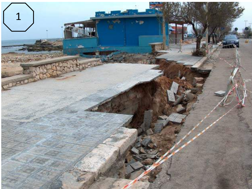
Fig. 12- 13 - Cedimenti della carreggiata pedonale e parziale interessamento della sede stradale del lungomare di Casalabate; nel tratto costiero sud vede oramai posizionati gli edifici degli anni '60 e '70 sulla attuale spiaggia sommersa, essendo quella emersa stata completamente erosa in questo intervallo temporale; sullo sfondo, l'edificio diroccato degli ex uffici locali della GdF, coincidente con il limite amm.vo tra i comuni costieri di Squinzano e Trepuzzi
