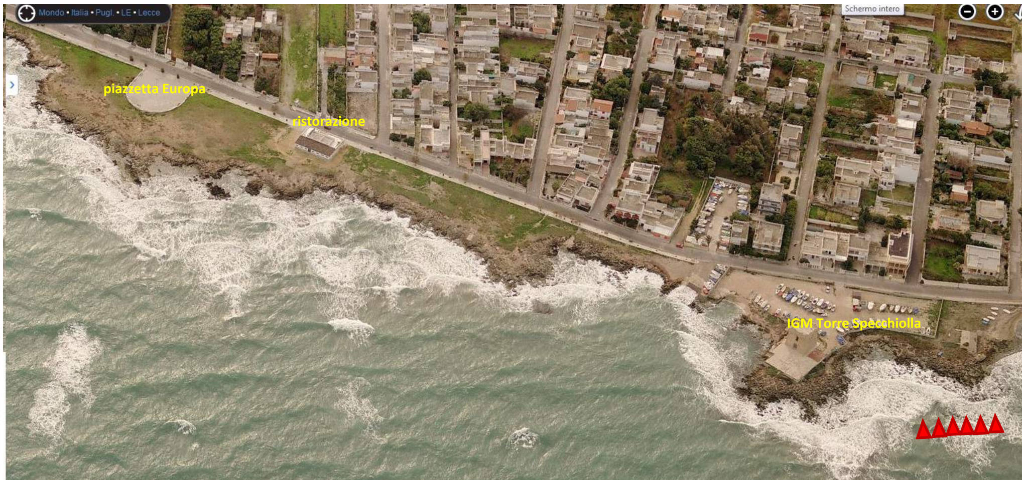
Figura 25 – 5° focus erosivo – a meno di 200 mt a nord di Torre Specchiolla, rilevato uno dei focus erosivi che incidono direttamente sulla infrastruttura viaria litoranea; la costa si presenta nella forma tipica bassa e rocciosa laddove il substrato calcarenitico si caratterizza per alimentare piccole e contigue pocket beach sabbioso-ciottolose; anche qui si manifestano processi erosivi ma, fortunatamente l'urbanizzazione incontrollata (anni '60 - '80), non si è localizzata direttamente sul margine costiero.
