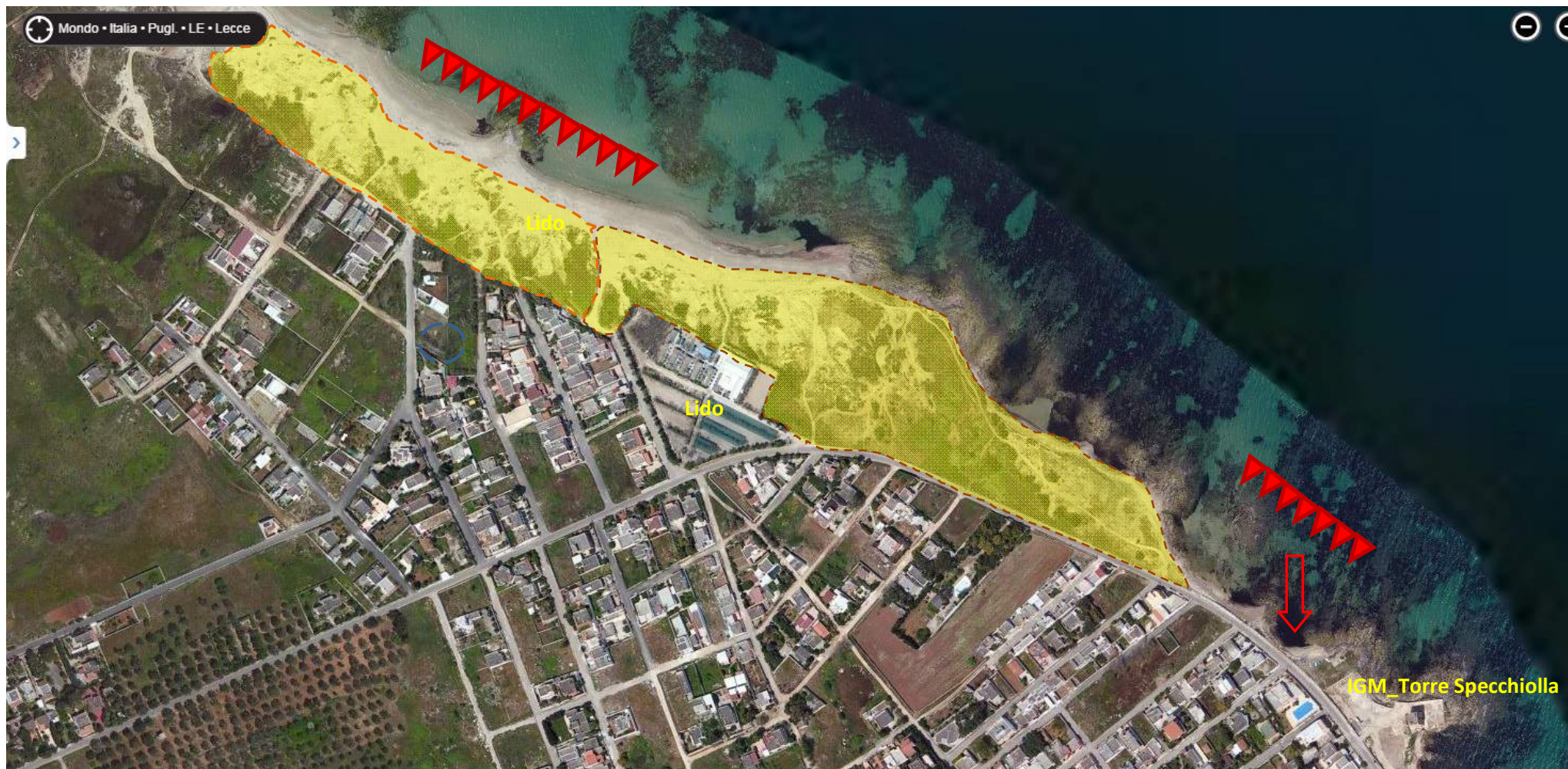
Figura 32 - 5° e 6° focus erosivo; marina di Casalabate, a nord Torre Specchiolla: è un tratto litorale specifico per le problematiche connesse, riguardanti sia il cordone dunale che l'infrastruttura viaria, entrambi interessati da dissesti da fenomeni erosivi costieri e che, pertanto devono essere oggetto di un piano di monitoraggio.
