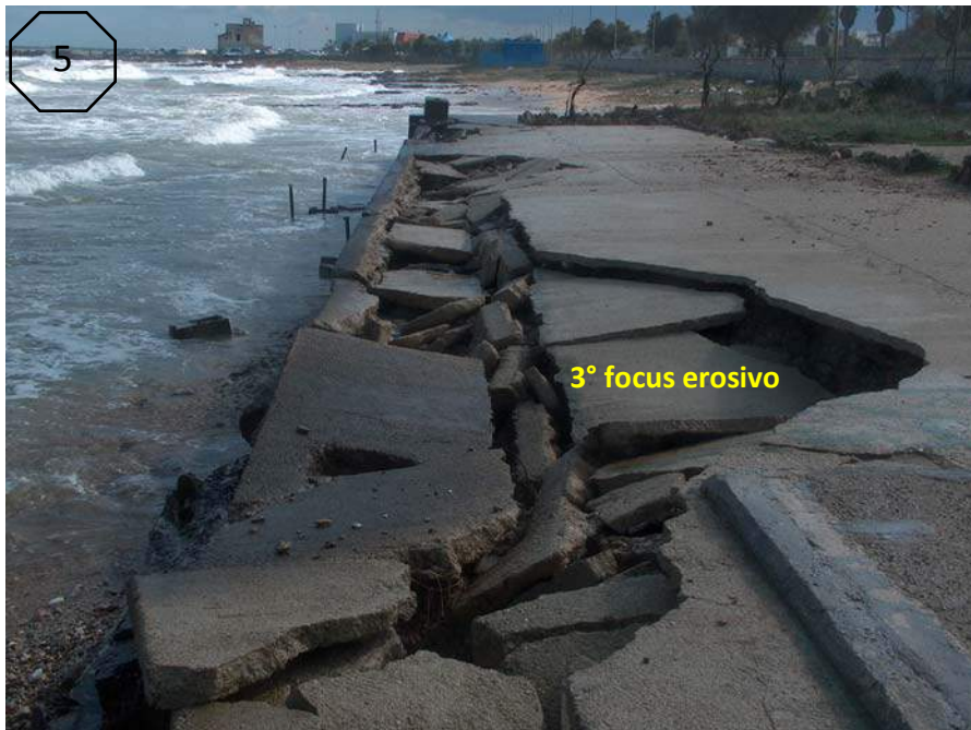
Fig. 21- 22 - Il tentativo di controllare il margine costiero mediante banchinamenti in cls non ha prodotto i risultati attesi, con l'evidenza della demolizione delle opere realizzate;
