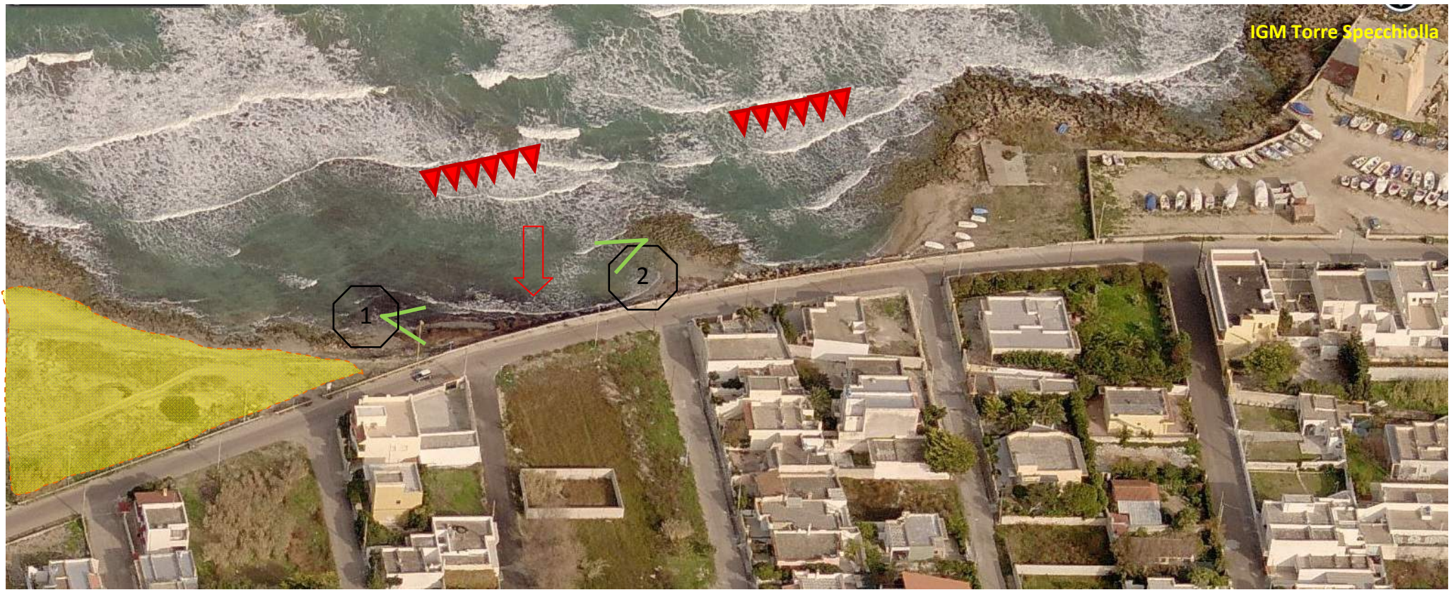
Figura 26 – 5° focus erosivo – L’infrastruttura viaria della strada litoranea nel punto di tangenza con il fronte mare, localizzato nel tratto che individua due piccole pocket beach contigue; questa recente interfaccia mare-strada si è determinata progressivamente nel corso degli ultimi venti anni a causa dell’incipiente fenomeno erosivo costiero che ha interessato il litorale.
