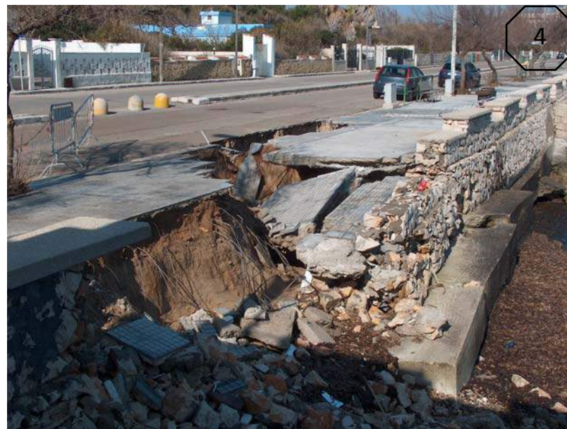
Fig. 14- 15 - La costa bassa interessata da fratture e disarticolazioni del substrato roccioso dovute alle mareggiate incidenti, spesso amplificate da interventi impropri eseguiti da privati che sbancano la scogliera al fine di realizzare un comodo accesso a mare alle imbarcazioni private; lo scavernamento alla base del rilevato del lungomare ha generato fenomeni di dissesto geotecnico del pendio
