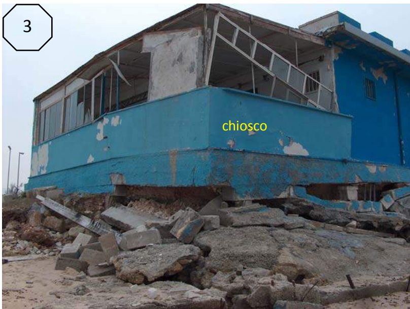
Fig. 14- 15 - La costa bassa interessata da fratture e disarticolazioni del substrato roccioso dovute alle mareggiate incidenti, spesso amplificate da interventi impropri eseguiti da privati che sbancano la scogliera al fine di realizzare un comodo accesso a mare alle imbarcazioni private; lo scavernamento alla base del rilevato del lungomare ha generato fenomeni di dissesto geotecnico del pendio
