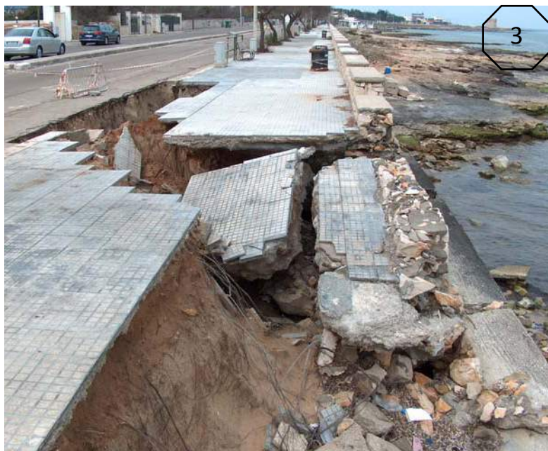
Fig. 9 – 10 - L'avanzata dei processi erosivi ha progressivamente collocato taluni tratti della sede del lungomare sulla spiaggia sommersa ed oltre la dividente demaniale; ciò a causa del progressivo arretramento della spiaggia emersa ( pocket beach ), oramai completamente scomparsa. Su questo tratto si propone la modifica della Criticità da C1 a C3
