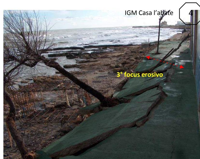
Fig. 19- 20 - 3° focus erosivo - Ancora una evidenza del dissesto del margine costiero irrigidito; sostanzialmente, l' arretramento della linea di costa , ha collocato le strutture balneari sul limite variabile della spiaggia emersa-sommersa, stante una collocazione avanzata lato mare delle strutture stesse.
