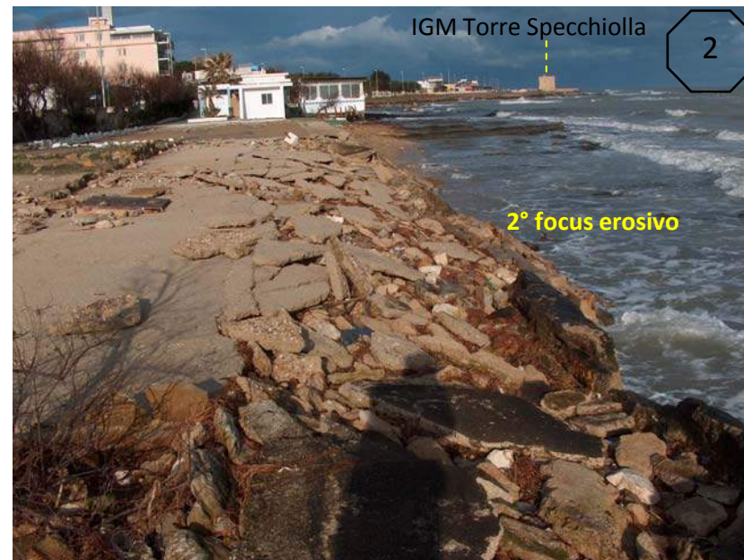
Fig. 17- 18 - 3° focus erosivo - Il tentativo di controllare il margine costiero mediante banchinamenti in cls non ha prodotto i risultati attesi, con l'evidenza della demolizione delle opere realizzate; viste a nord (2) e vista a sud (1)
