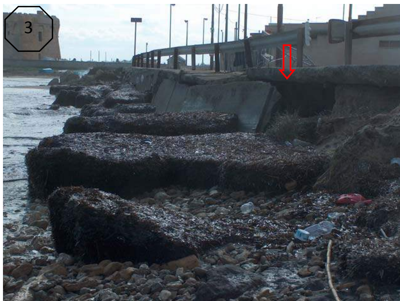
Fig. 30 - 31 – la linea di costa, essendo dinamica, attiva ed in evoluzione, mal si concilia con opere rigide riflettenti che accentuano il livello erosivo della spiaggia; banquette derivanti dallo spiaggiamento del posidonieto strappato ai fondali durante le mareggiate; il tratto costiero dopo i lavori di ripristino e consolidamento del rilevato stradale.
