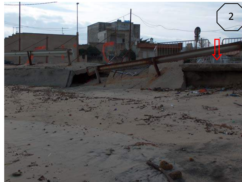
Fig. 28 - 29 - 5° focus erosivo – ca. 150 mt nord di Torre Specchiolla (IGM), la strada litoranea è direttamente a contatto con la linea di costa; il tratto stradale è tangente alla linea di riva, ed è sollecitato dall'energia del moto ondoso incidente, tale da provocare ricorrentemente dissesti geotecnici sul fianco del rilevato stradale ( scavernamenti , cedimenti, crolli parziali) sui quali si interviene in modo tradizionale ed in emergenza; fino al ripetersi periodicamente del fenomeno.
