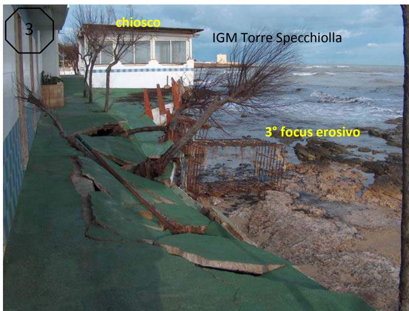
Fig. 19- 20 - 3° focus erosivo - Ancora una evidenza del dissesto del margine costiero irrigidito; sostanzialmente, l' arretramento della linea di costa , ha collocato le strutture balneari sul limite variabile della spiaggia emersa-sommersa, stante una collocazione avanzata lato mare delle strutture stesse.
