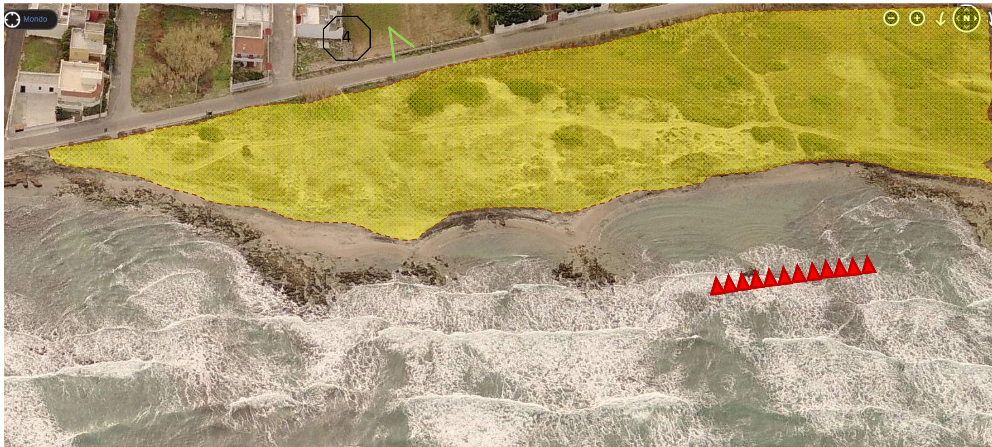
Figura 34 - 6° focus erosivo : limite sud del cordone dunale che inizia poco a nord di Torre Specchiolla e si sviluppa, quasi senza soluzioni di continuità, fino al limite con la marina di “Lindinuso” (comune di Torchiarolo).
