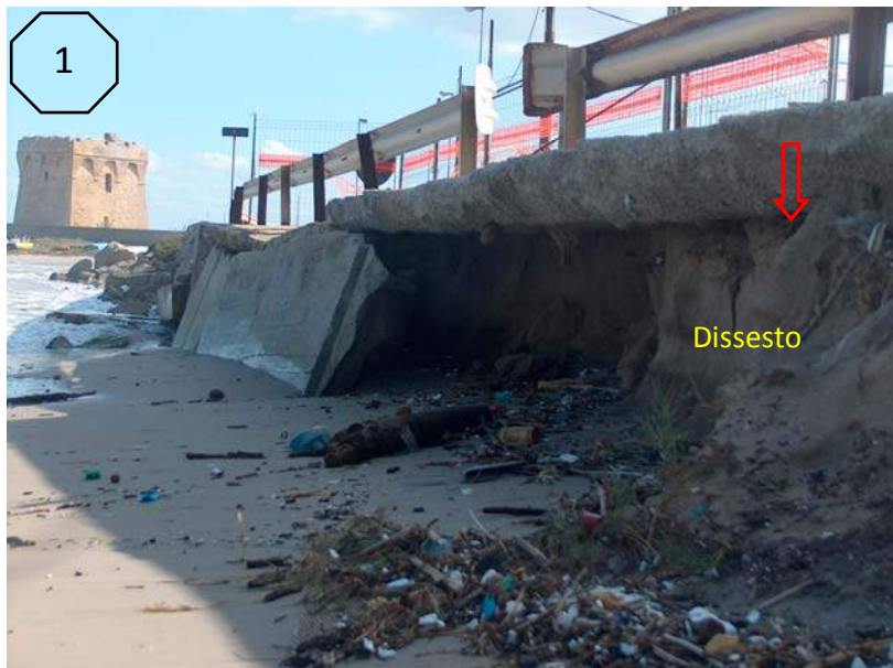
Fig. 28 - 29 - 5° focus erosivo – ca. 150 mt nord di Torre Specchiolla (IGM), la strada litoranea è direttamente a contatto con la linea di costa; il tratto stradale è tangente alla linea di riva, ed è sollecitato dall'energia del moto ondoso incidente, tale da provocare ricorrentemente dissesti geotecnici sul fianco del rilevato stradale ( scavernamenti , cedimenti, crolli parziali) sui quali si interviene in modo tradizionale ed in emergenza; fino al ripetersi periodicamente del fenomeno.
