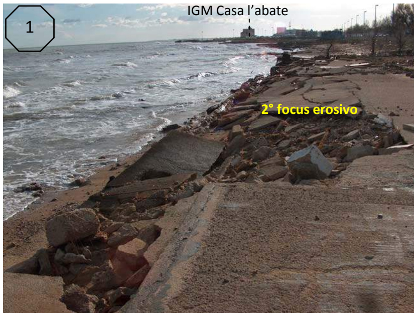
Fig. 17- 18 - 3° focus erosivo - Il tentativo di controllare il margine costiero mediante banchinamenti in cls non ha prodotto i risultati attesi, con l'evidenza della demolizione delle opere realizzate; viste a nord (2) e vista a sud (1)
