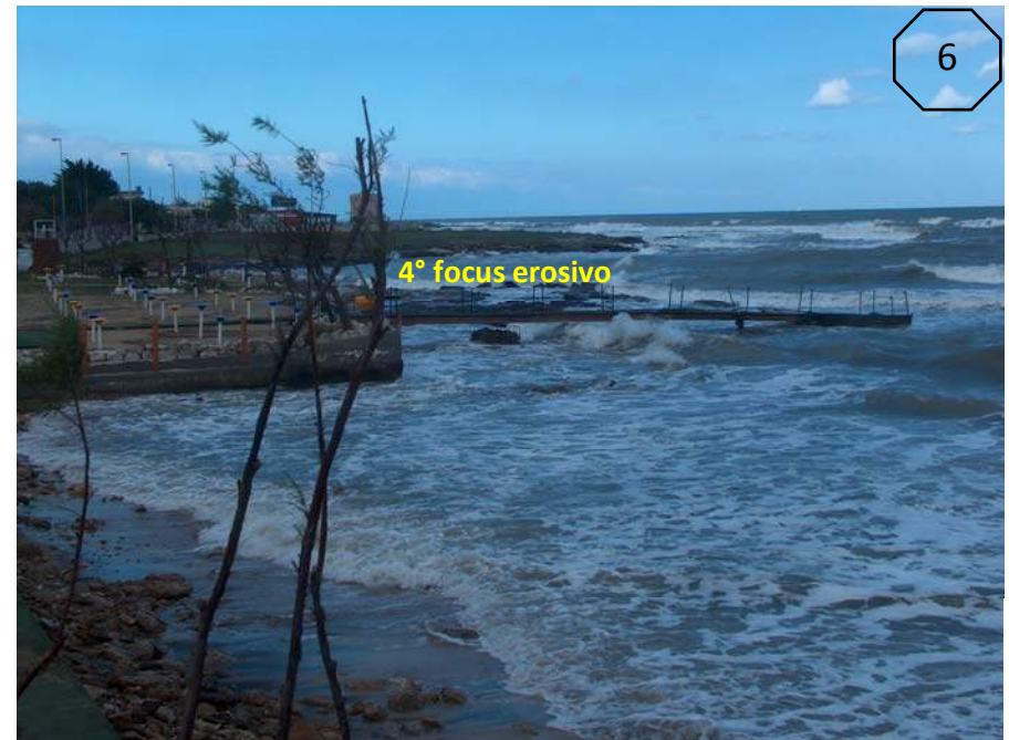
Fig. 21- 22 - Il tentativo di controllare il margine costiero mediante banchinamenti in cls non ha prodotto i risultati attesi, con l'evidenza della demolizione delle opere realizzate;
