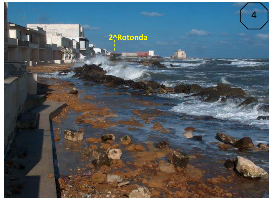
Nonostante il ripascimento protetto, gli edifici continuano ad essere flagellati dalle mareggiate più intense che, riescono agevolmente a superare la scogliera di protezione radente
