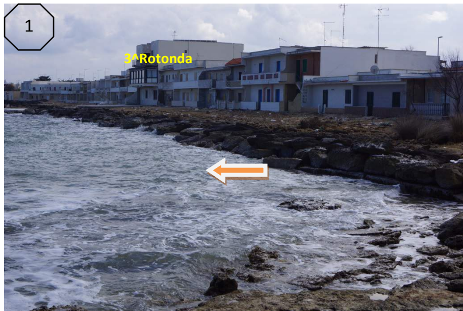
Figura 10 - 3° focus erosivo: Il lembo roccioso della costa bassa a sud della 3^a rotonda è il limite di un intervento tampone eseguito con pietrame e sabbie a protezione degli edifici che ricadevano oramai sulla spiaggia sommersa essendosi, negli ultimi 25 anni, completamente erosa la spiaggia emersa.
