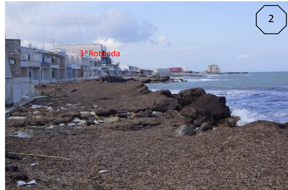
L’ex stabilimento balneare “Mongìò”: la scogliera radente fronte mare a protezione del riempimento con inerti di varia pezzatura; la cella è stata colmata con sabbia al fine di livellare e rendere fruibile il piano calpestio; si noti lo spiaggiamento della Posidonia sulla spiaggia emersa ricostruita, fino al limite degli edifici
