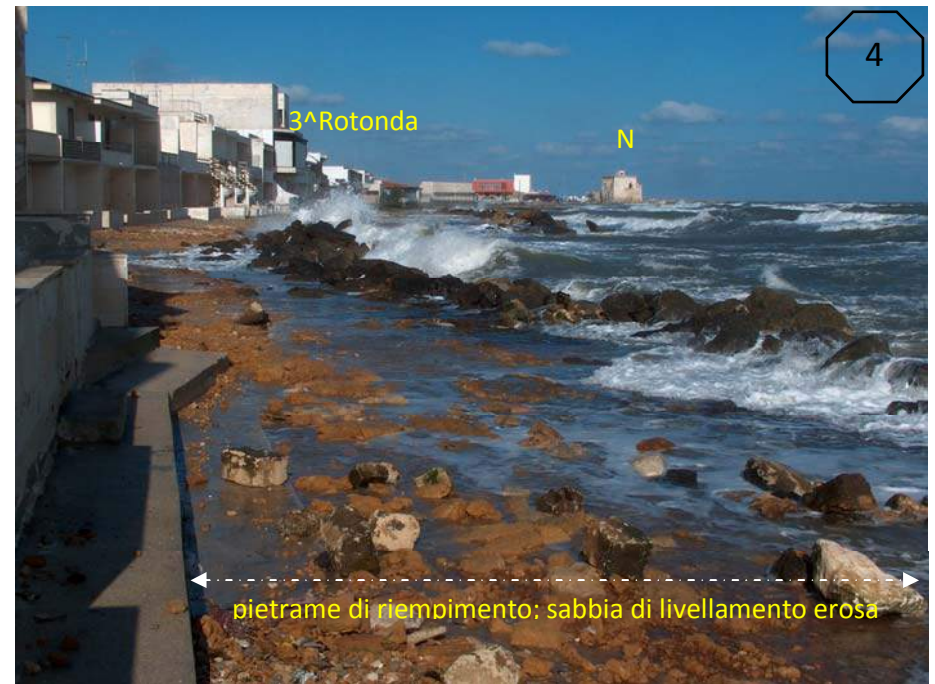
4° focus erosivo: 'ripascimento protetto' con materiali lapidei calcarenitici a tergo della scogliera
