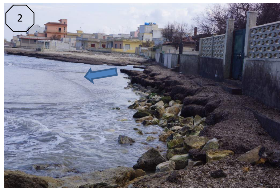
Vista a nord sugli edifici oggetto di intervento di difesa mediante “ripascimento protetto” con scogliera bassa a protezione di un riempimento in materiali lapidei calcarenitici; il punto ove trova sfogo il deflusso della falda profonda che incontra la linea di riva, con la localizzazione di una sorgente costiera in prossimità del margine di un edificio
