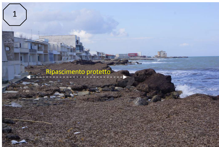
Vista a nord sugli edifici oggetto di intervento di difesa mediante “ripascimento protetto” con scogliera bassa a protezione di un riempimento in materiali lapidei calcarenitici; il punto ove trova sfogo il deflusso della falda profonda che incontra la linea di riva, con la localizzazione di una sorgente costiera in prossimità del margine di un edificio
