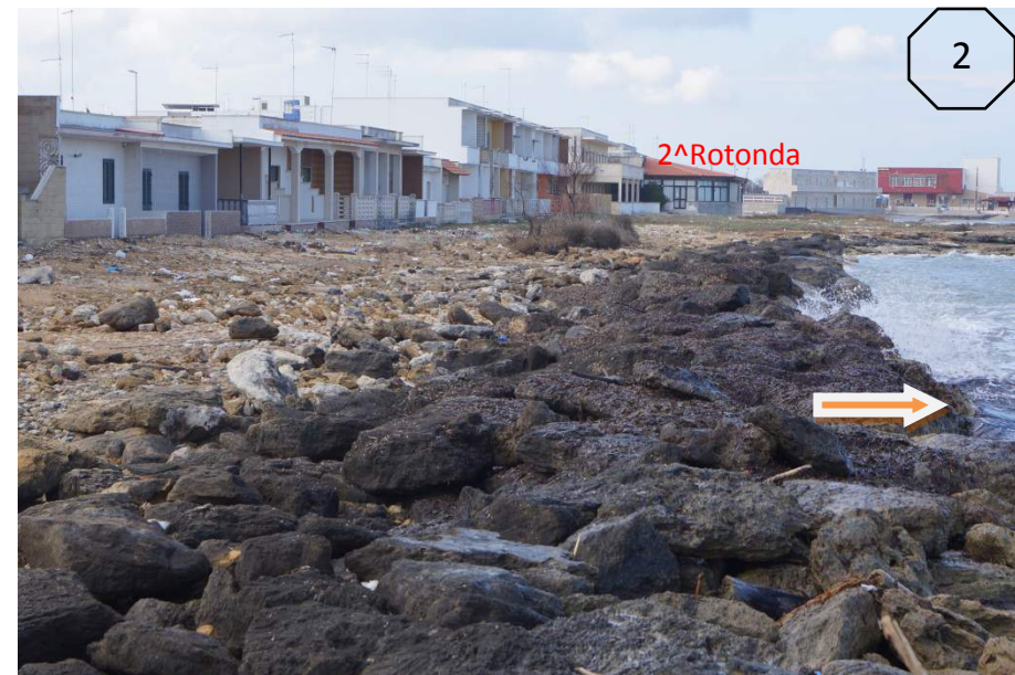
Figura 10 - 3° focus erosivo: Il lembo roccioso della costa bassa a sud della 3^a rotonda è il limite di un intervento tampone eseguito con pietrame e sabbie a protezione degli edifici che ricadevano oramai sulla spiaggia sommersa essendosi, negli ultimi 25 anni, completamente erosa la spiaggia emersa.
