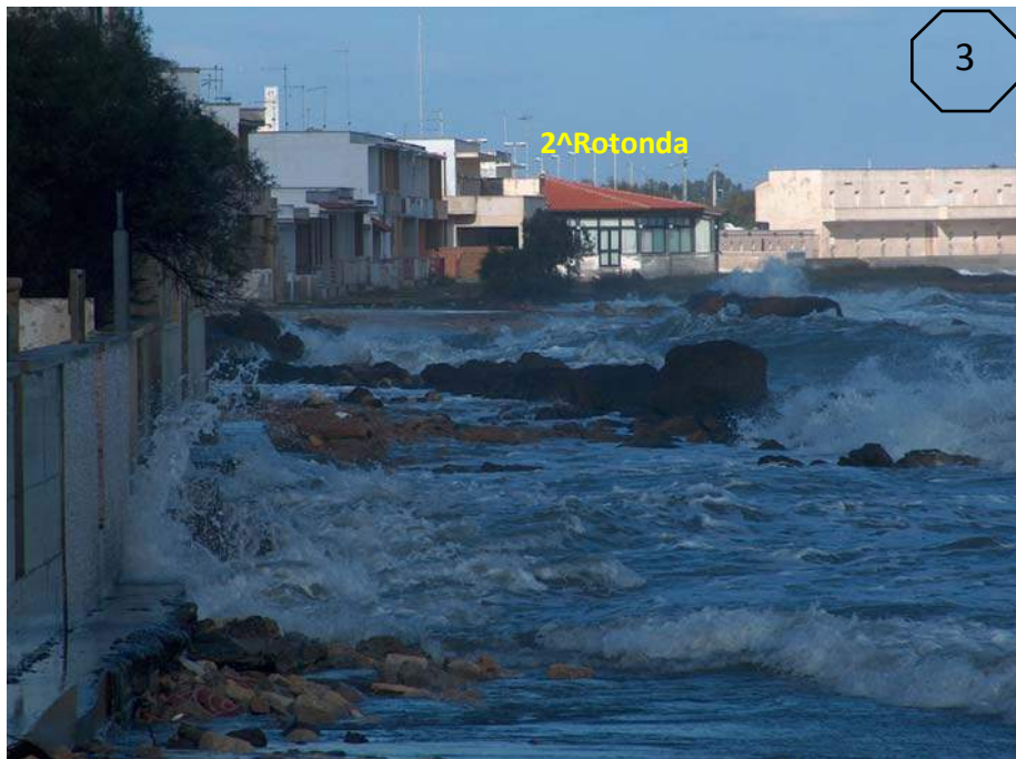
Nonostante il ripascimento protetto, gli edifici continuano ad essere flagellati dalle mareggiate più intense che, riescono agevolmente a superare la scogliera di protezione radente
