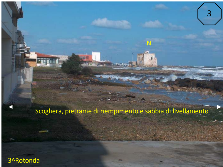
3° focus erosivo: ripascimento protetto con cui si tenta di salvaguardare gli edifici
