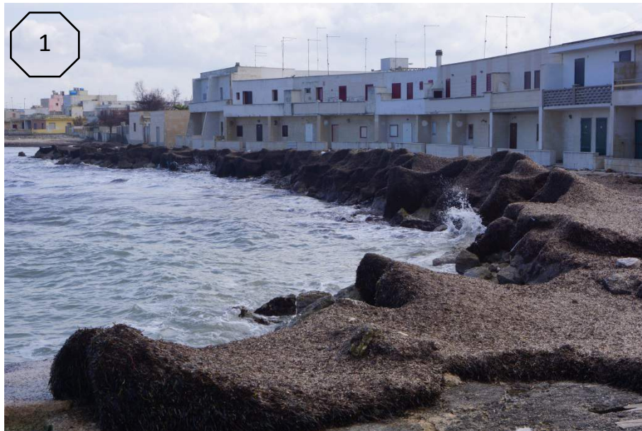
L’ex stabilimento balneare “Mongìò”: la scogliera radente fronte mare a protezione del riempimento con inerti di varia pezzatura; la cella è stata colmata con sabbia al fine di livellare e rendere fruibile il piano calpestio; si noti lo spiaggiamento della Posidonia sulla spiaggia emersa ricostruita, fino al limite degli edifici
