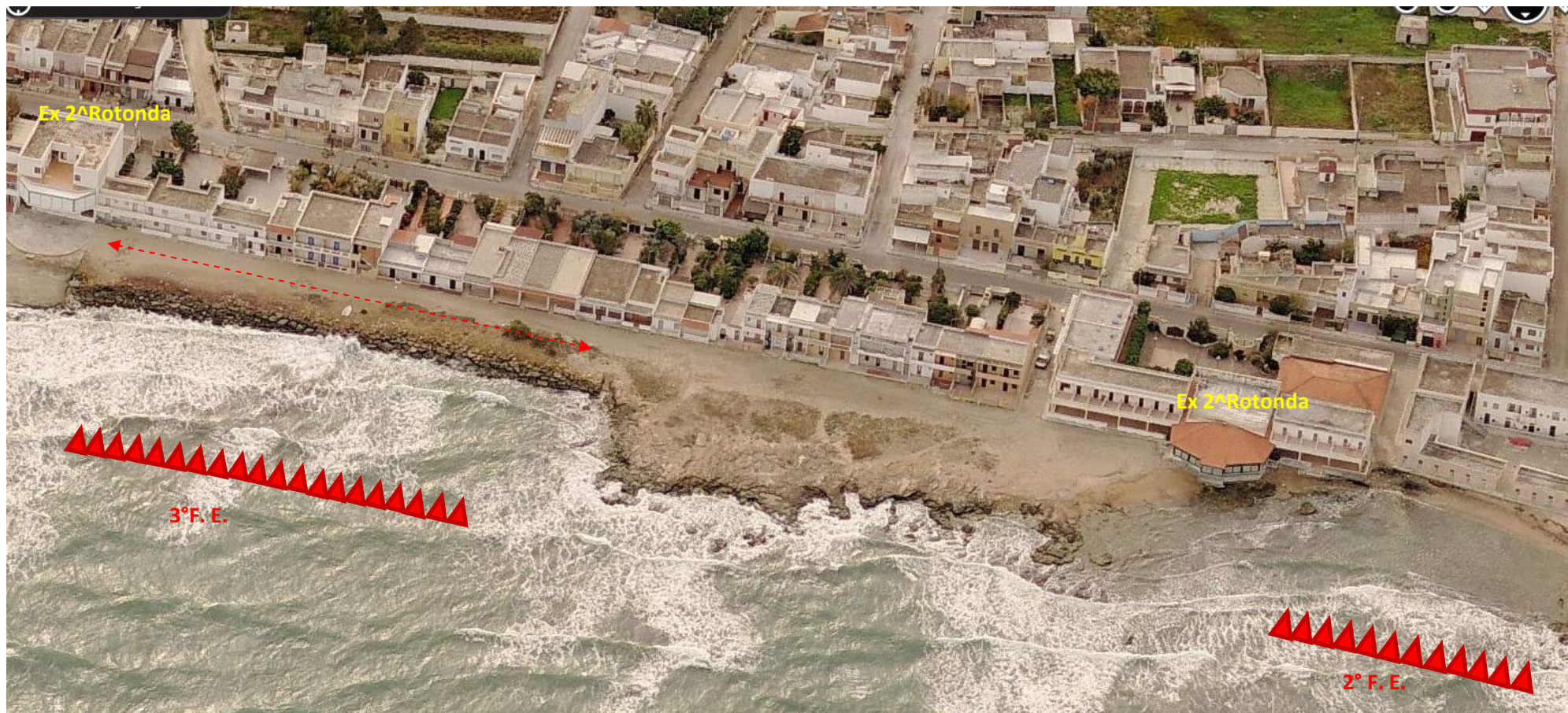
Figura 11 - 2° e 3° focus erosivo - negli ultimi anni, il tratto litorale (3°f.e.) è stato oggetto di un ripascimento protetto, con una scogliera radente fronte mare a chiusura di un 'riempimento' in pietrame, quest'ultimo nascosto da una coltre di livellamento sabbioso superficiale
