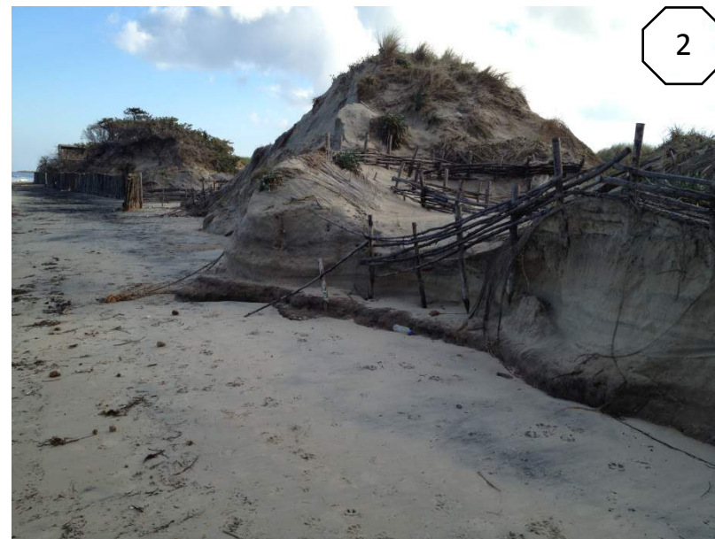
I lavori di consolidamento e stabilizzazione del cordone dunale di “posto dei Trepuzzi” (IGM sc. 1:25.000) poco o nulla hanno potuto contro l’energia del moto ondoso incidente
