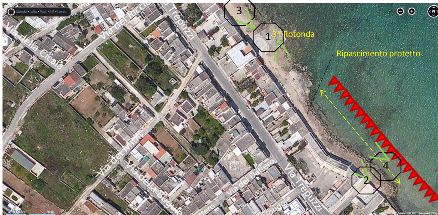
Figura 12 - 4° focus erosivo – gli edifici a sud della 3 a rotonda sono anch’essi stati oggetto di un intervento di difesa mediante un “ripascimento protetto”; trattasi in realtà di un riempimento con inerti lapidei sui quali è stata deposto uno strato di sabbia. Questo cassetto di ripascimento è stato chiuso fronte mare con una scogliera bassa costituita da massi calcarenitici
