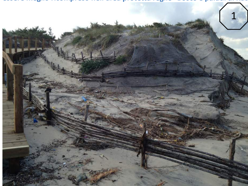
I lavori di consolidamento e stabilizzazione del cordone dunale di “posto dei Trepuzzi” (IGM sc. 1:25.000) poco o nulla hanno potuto contro l’energia del moto ondoso incidente
